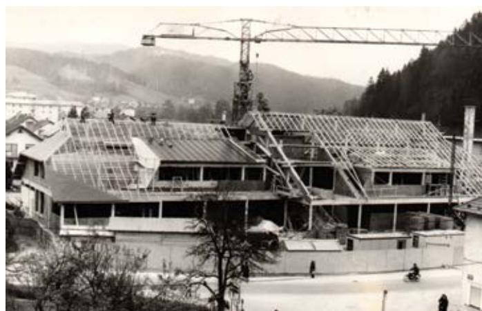
Blagovnica med gradnjo. Odprta je bila 30. julija 1989. Arhiv Alpina
