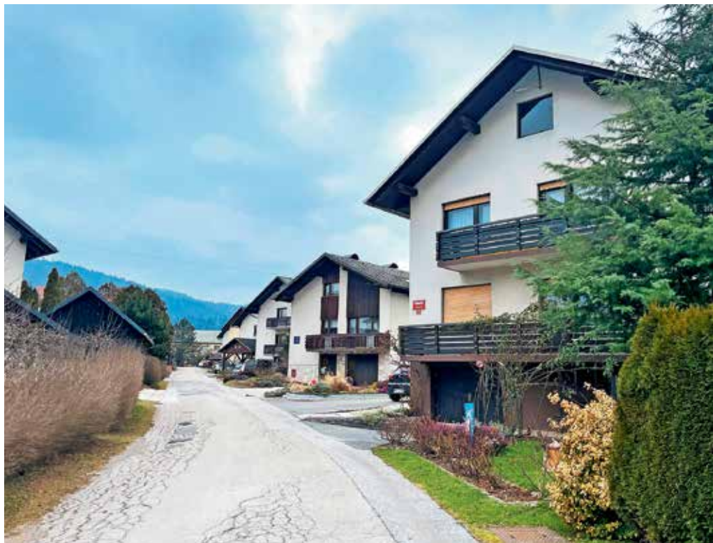
Obnovo vodovodnega omrežja bodo začeli v Prvomajski ulici. Foto: Tanja Mlinar
