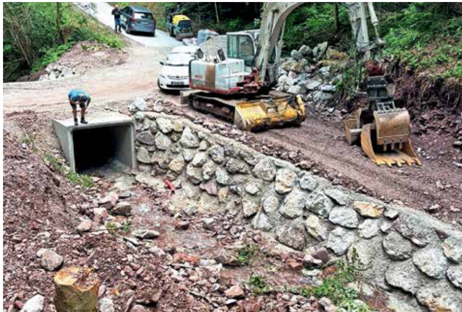
Urejanje struge hudourniškega potoka ob lokalni cesti Pretovč–Mostar
