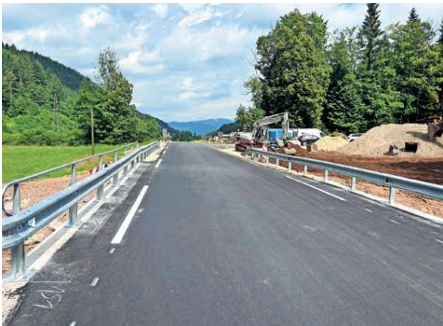
Obnovljena cesta v Račevi Foto: arhiv občine
